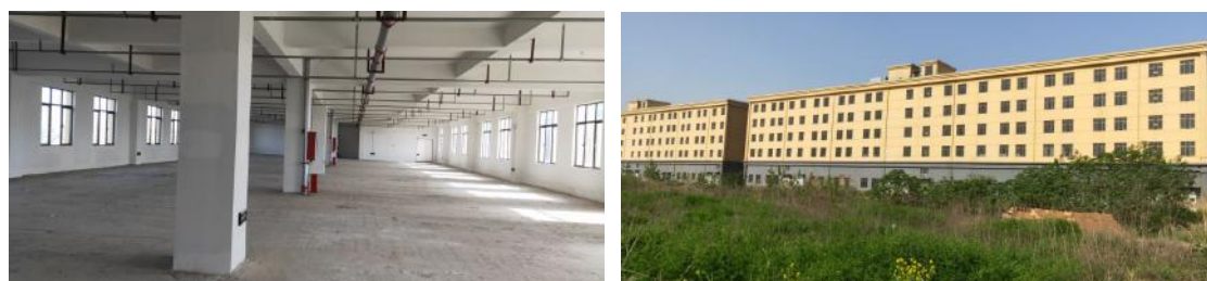
图 3-1 场地建设现状
